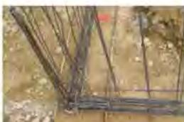
Nœud de chaînage - Continuité mécanique
