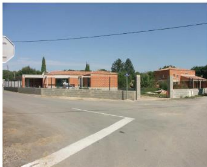
Extension résidentielle le long du chemin de la Rouvière
