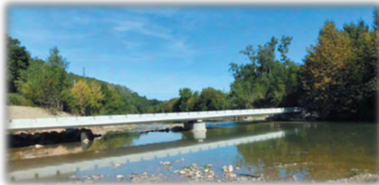
Vue de la réhabilitation du seuil et passerelle de la Clotte (Source : SIAV)
