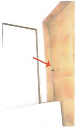
Affaississement du plancher mis en évidence par le décollement entre plinthes et dallage - Maison Jourdan.
